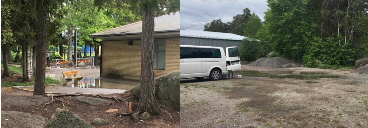
Figur 7. Foton från platsbesök på de två områden där vatten observerades bli stående. Till vänster visas området i det nordvästra hörnet och till höger visas området söder om befintlig boulehall.
