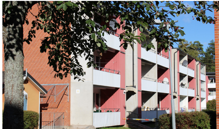
De kringbyggda gårdarna med balkongförsedda fasader. Kv Peterson-Berger.
