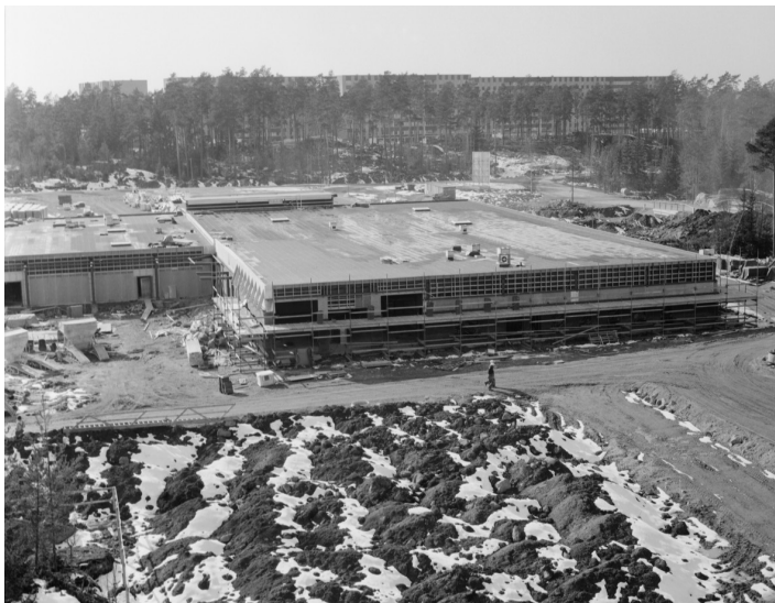
Byggandet av Gottsunda centrumläggning pågår. På höjdryggen bakom träden syns de nya skivhusen i Norra Gottsunda.
