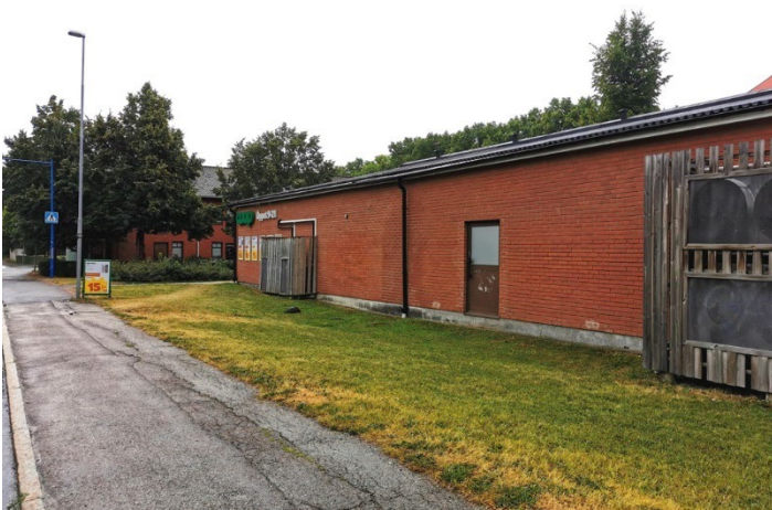
Den nuvarande butikens fasad ut mot Nordengatan.
