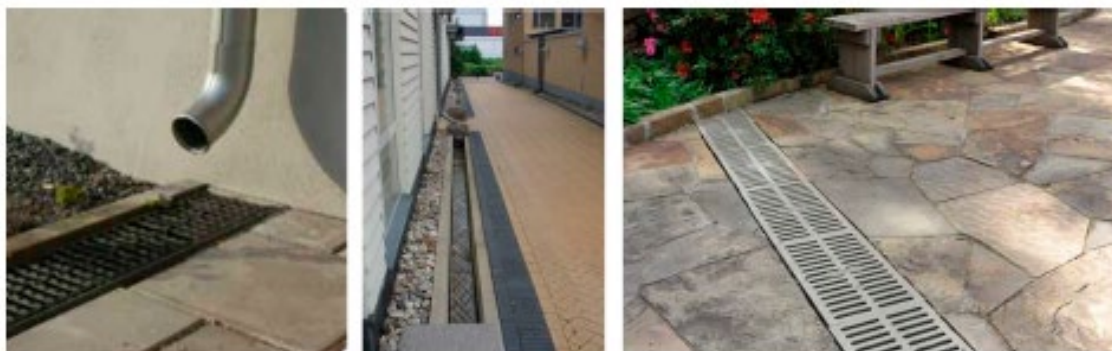
Exempel på olika typer av takvattenavledning via rännor, ränna med galler (till vänster), avledning via öppna rännor (mitten) och ränna med galler som leder dagvatten till växtbädd (till höger). Foto: Uppsala Vatten och Avfall, WRS, AI Guaranteed (2012).
