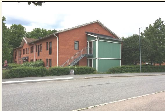
Gruppboende uppfört av Uppsalahem, Flogsta 17:2, sekundär tillbyggnad på gaveln mot Nordengatan, kvarteret Tavastehus.
