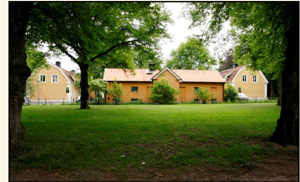
Två f.d. arbetarbostäder flankerar en ekonomibyggning ombyggd till bostäder, Flogsta 11:15. I förgrunden en öppen gräsyta flankerad av lindar, platsen för två på 1970-talet rivna f.d. arbetarbostäder.
