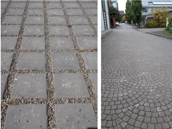
Figur 19. Exempel på genomsläpplig beläggning – betonghålsten och plattor med fogar. Foto: WRS.
