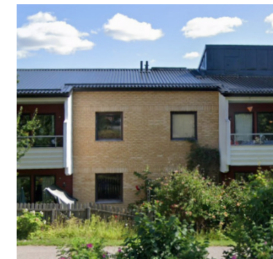
Inspiration: Ljust tegel och kvadratiska fönster Kvarteret Köpenhamn.
