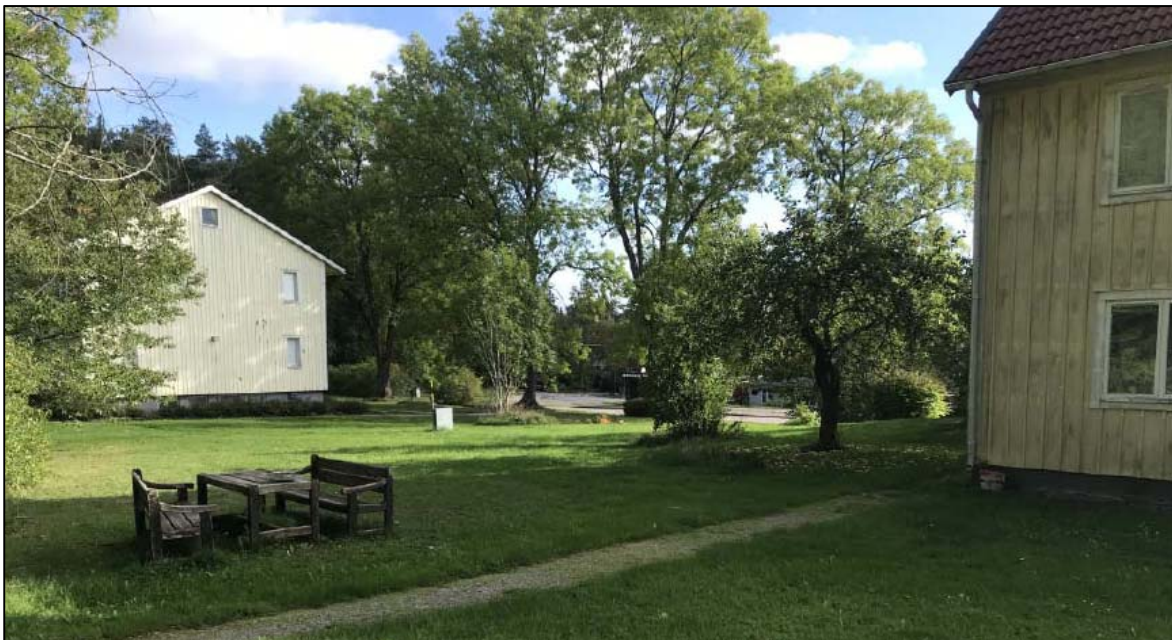
Inom fastigheten Löt 1:97 finns två flerbostadshus i två våningar. Foto från dagvattenutredning som Geosigma tagit fram.
