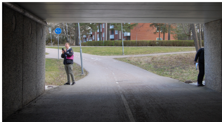
Befintlig miljö i GC-port.
