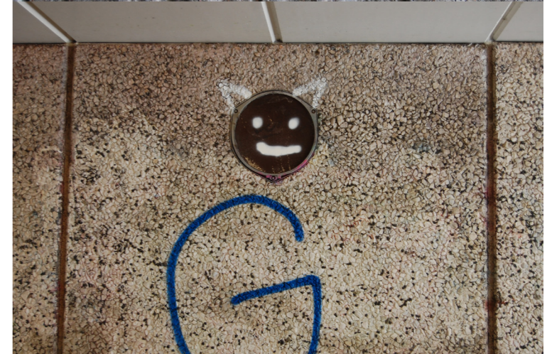
Platsbilder befintliga portar.
