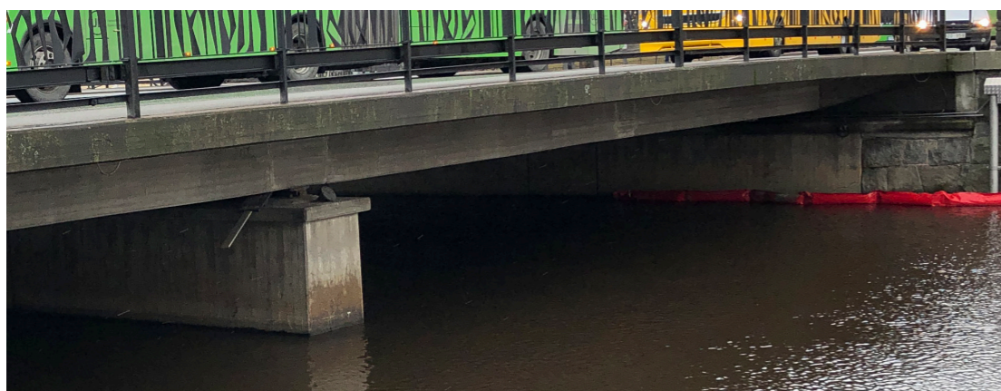
Bilden visar bronns nedböjning vid mellanstödet.
