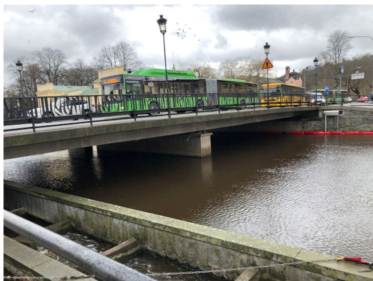
Vattenrummet under bron med asptrappa.
