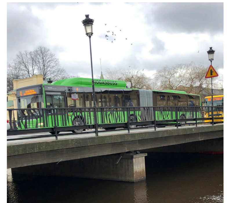
Nedböjning/deformation över mittstödet.
