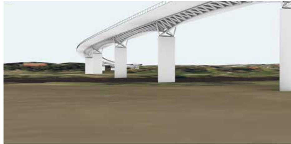
Exempel med rymdfackverk
