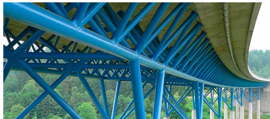
Autobahnbrücke St. Kilian
