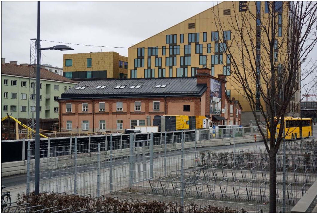
I kvarteret Fjalar finns en fabriksbyggnad från slutet av 1800-talet bevarad.
