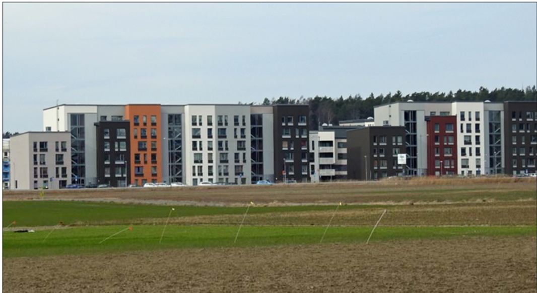
I Bäcklösa, som har varit en del av Ultuna, har ett nytt bostadsområde uppförts i korsningen mellan den nya vägen Gottsunda allé och Dag Hammarskjölds väg.
