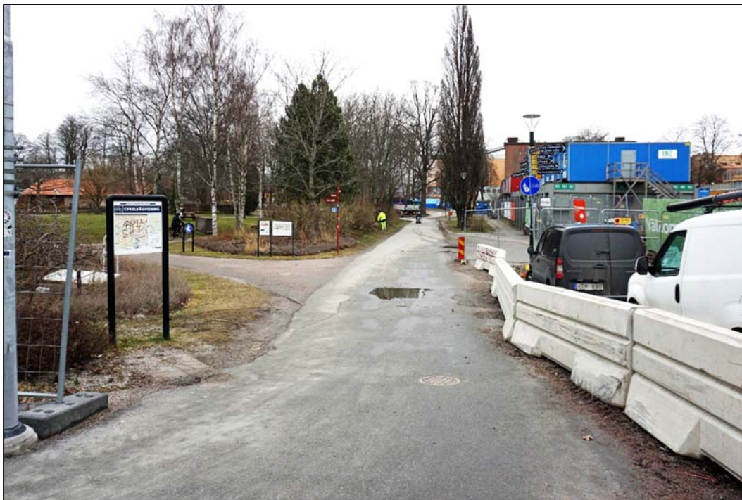
Gränsen mellan Studenternas idrottsplats, med den nya arenan under uppförande, och Stadsträdgården, utgörs av en mindre asfalterad väg.
