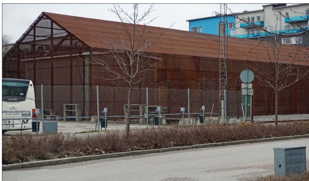
Ställverksbyggnad på Islandsgatan.
