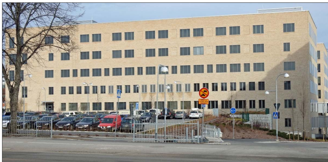
Vid korsningen mellan Dag Hammarskjölds väg och Sjukhusvägen har barn- och ungdomspsykiatriska kliniken från 1950-talet rivits och ersatts av nya klinikbyggnader.
