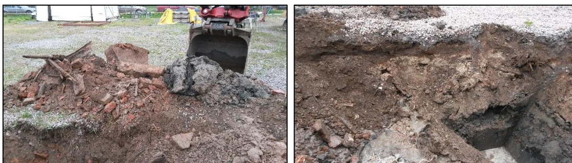
Figur 5: Till vänster: Provgrop 17T02 med stort inslag av rivningsrester i fyllnadsmassorna. Till höger: Provgrop 17T01 med inträngande vatten från gropens norra sida.
