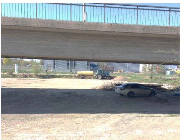
Parkering under Kungsängsbron, april 2019.
