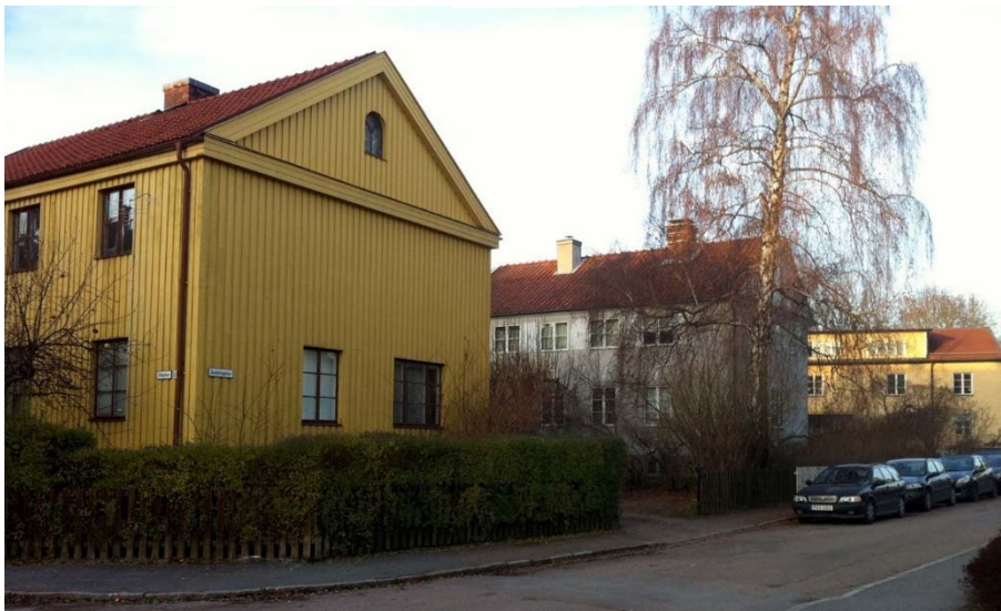
Bebyggelsens karaktär längs Jumkilsgatan. Från vänster ses bostadshusen inom planområdet, Luthagen 21:3 och 21:4. Både Luthagen 21:3 och Luthagen 21:5, längst till höger i bild, är ritade av Gunnar Leche och har förvanskats genom tilläggsisolering med nya fasadmaterial.
