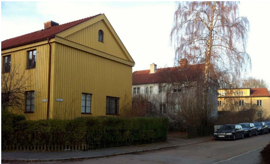
Bebyggelsens karaktär längs Jumbkilsgatan. Från vänster ses bostadshusen inom planområdet, Luthagen 21:3 och 21:4. Både Luthagen 21:3 och Luthagen 21:5, längst till höger i bild, är ritade av Gunnar Leche och har förvanskats genom tilläggsisolering med nya fasadmaterial.
