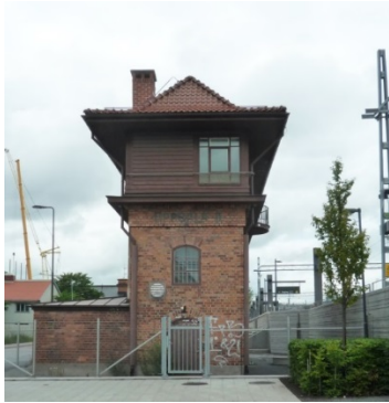
Sidovy ställverk (från söder).
