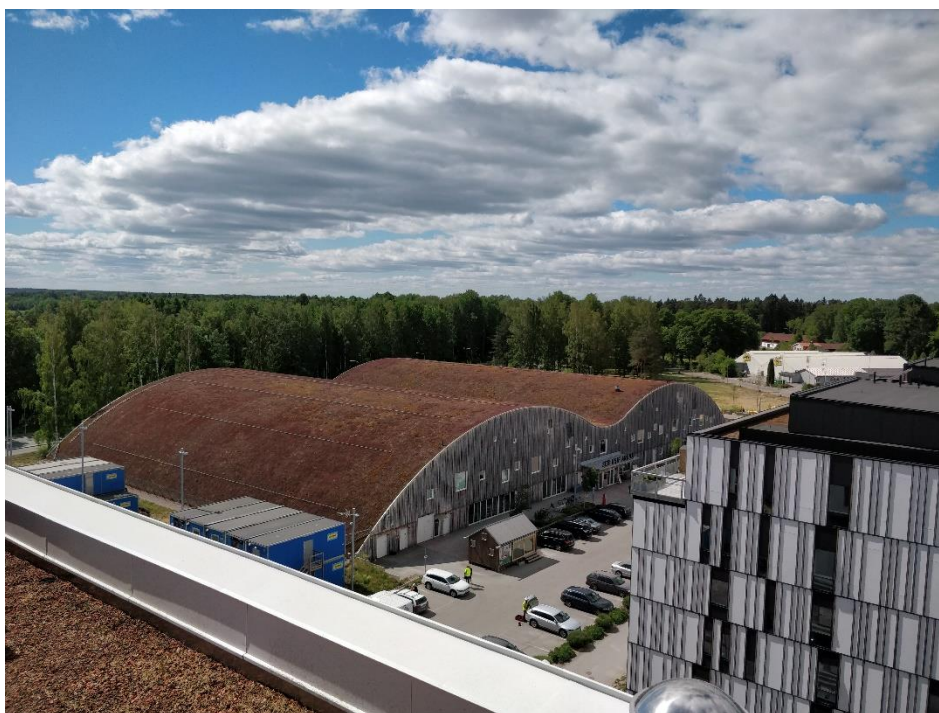
Figur 19. Exempel på ett extensivt tak på en byggnad. (Foto: Sweco)
