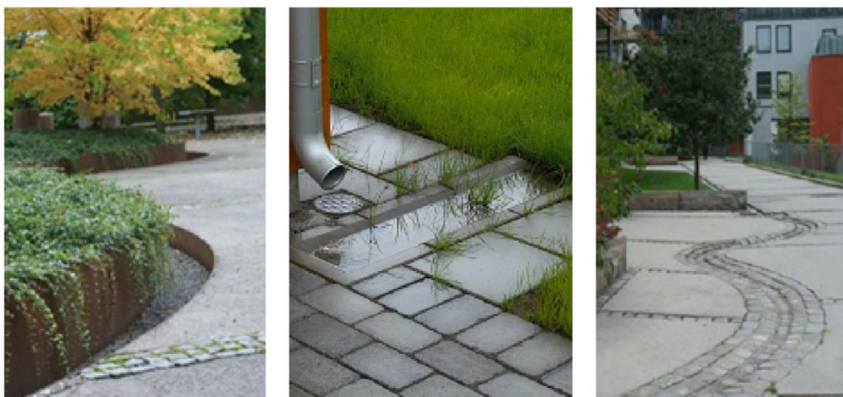
Figur 20. Exempel på utformning av dagvattenrännor i urban miljö. (Det högra och vänstra exemplet är foton från Sweco, exemplet i mitten kommer från S:t Eriks räändalsplattor)
