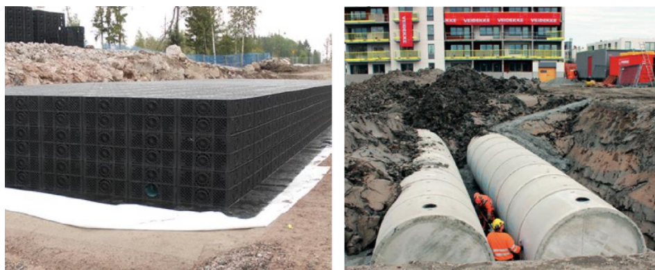
Figur 14. Exempel på hur avsättningsmagasin kan utformas. Den vänstra bilden är ett kassetmagasin och kommer från Uponor medan den högra föreställer ett rörmagasin och kommer från Meag Va-system.
