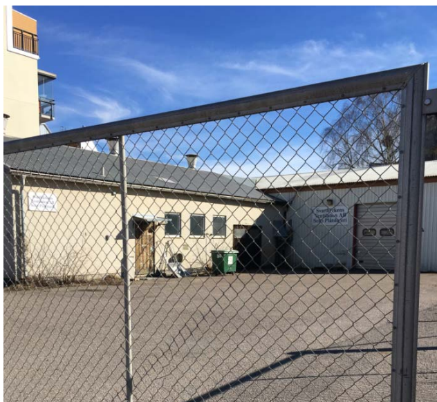
Foto av fastighet 12:9.
