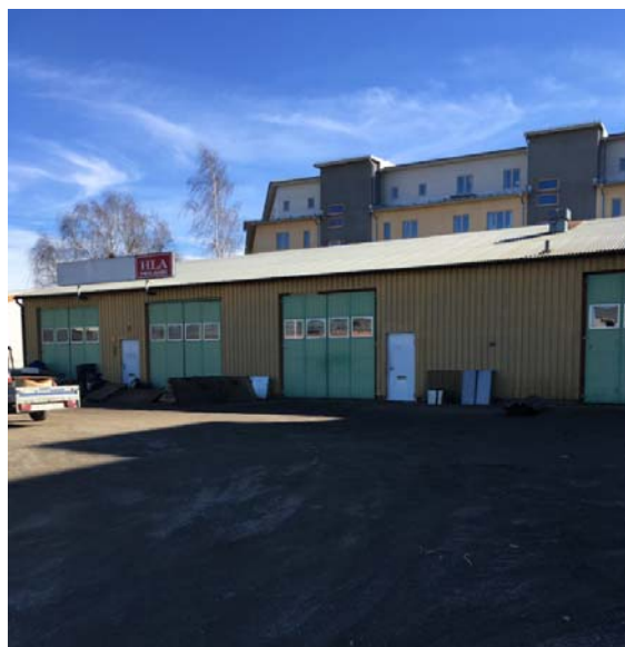
Foto av fastighet 12:8.
