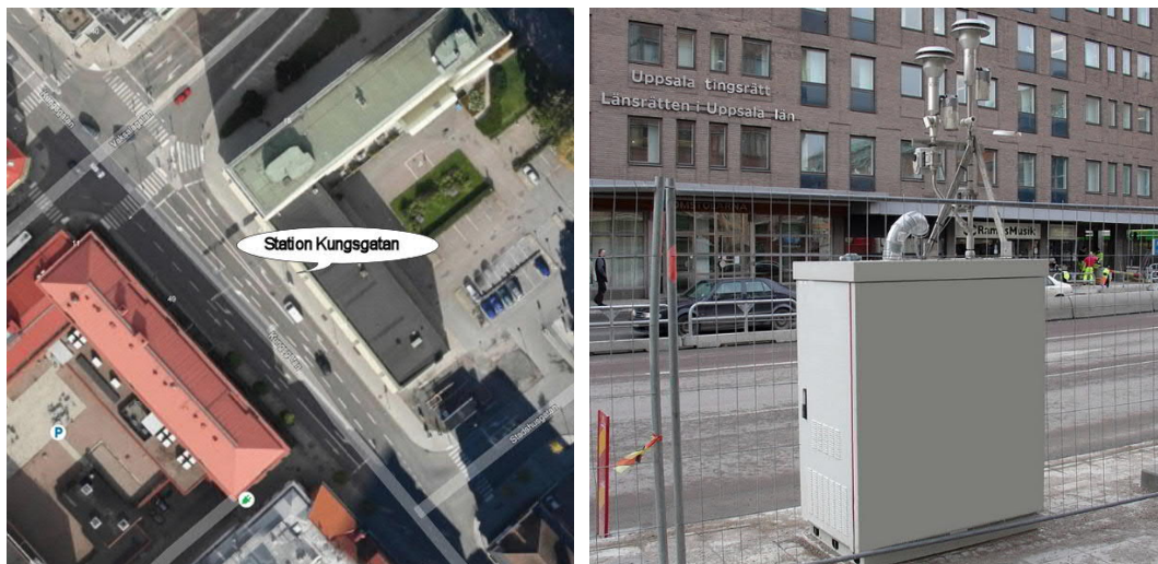
Figur 5 Mätstationen i gatuplanet på Kungsgatans nordöstra sida, mitt för nr 42/44. Källa hitta.se (vänster) och OSLVF hemsida (höger)
