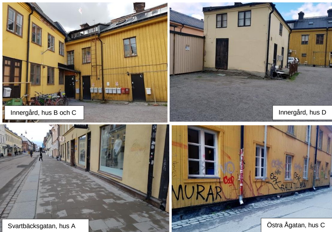
Figur 3. Fastigheten Dragarbrunn 6:2, fotograferad 2018-05-02. Foto: Tyréns AB.
