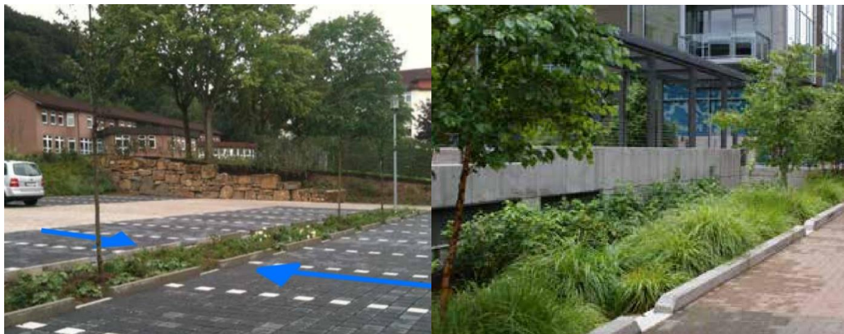
Figur 9. Exempel på regnbäddar från Uppsala Vatten AB:s exempelsamling (2014).
