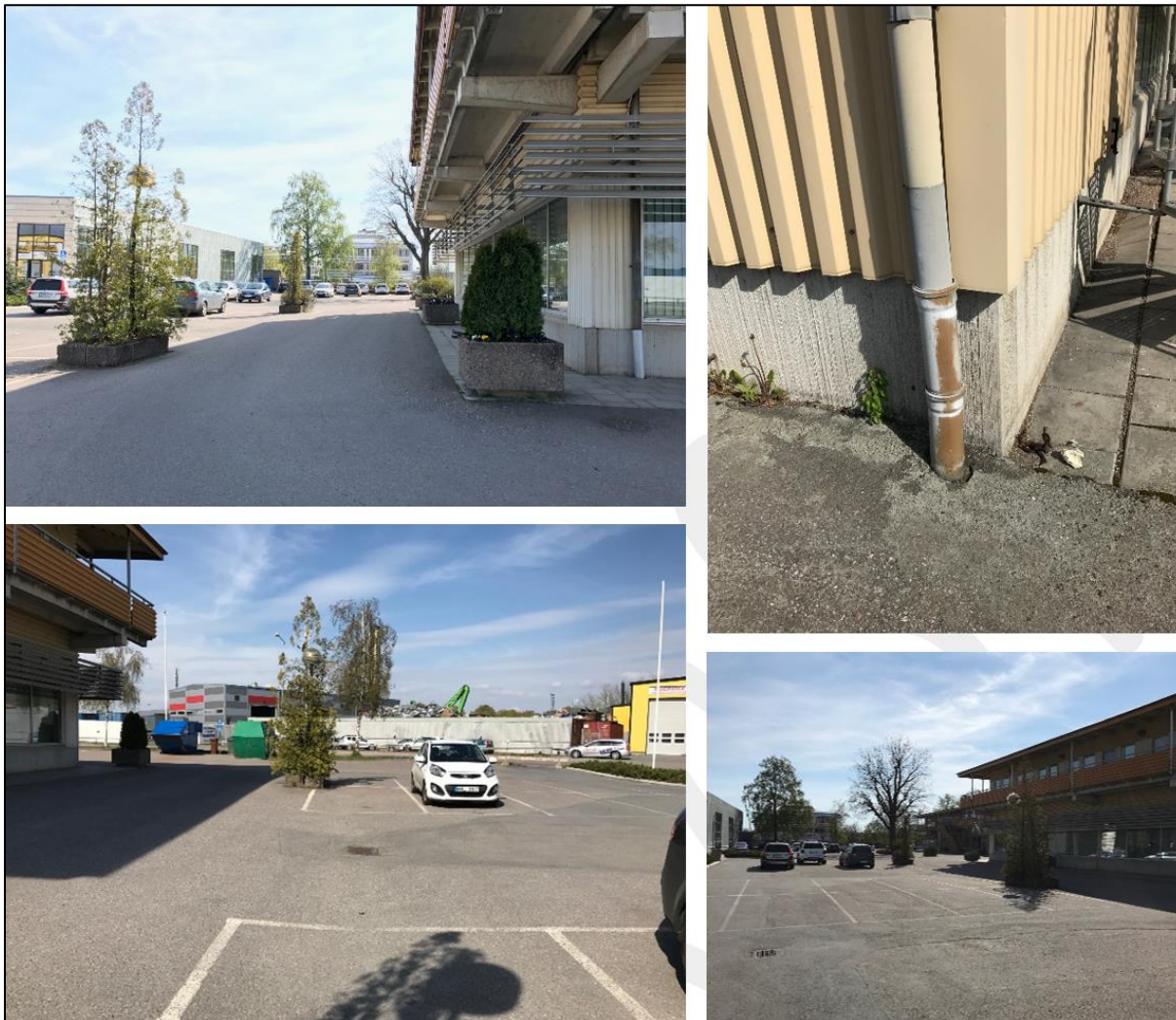
Figur 4. Uppe t.v: Befintliga planteringar har ej någon funktion för dagvattenhantering. Uppe t.h: Stuprör går ner i mark. Nere: Parkeringsytan avvattnas med dagvattenbrunnar. Foto: Ingela Filipsson
