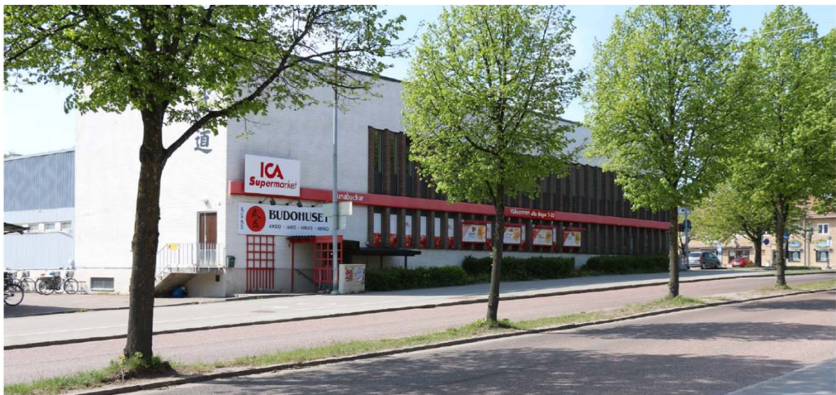
Befintlig byggnad med vissa kulturhistoriska värden.
