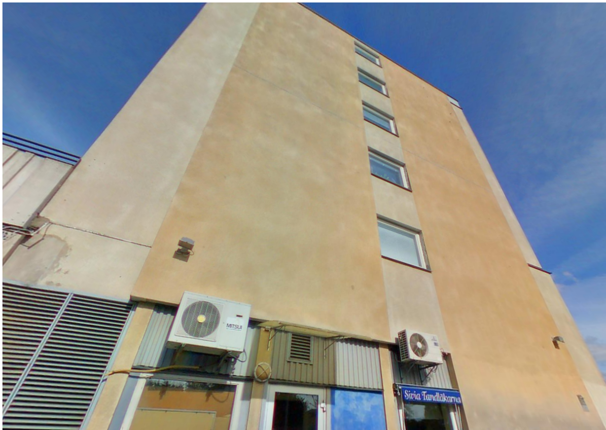
Figur 10. Fasad i befintlig byggnad som vetter mot järnvägen.
