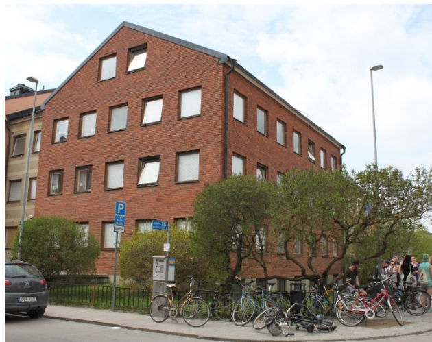
Den aktuella byggnaden sedd från S:t Larsgatan söderifrån.
