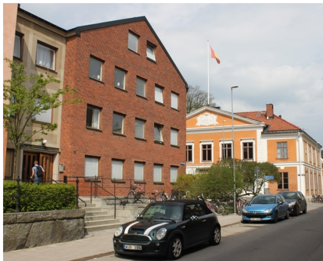
Den aktuella byggnaden sedd från S:t Johannesgatan västerifrån.
