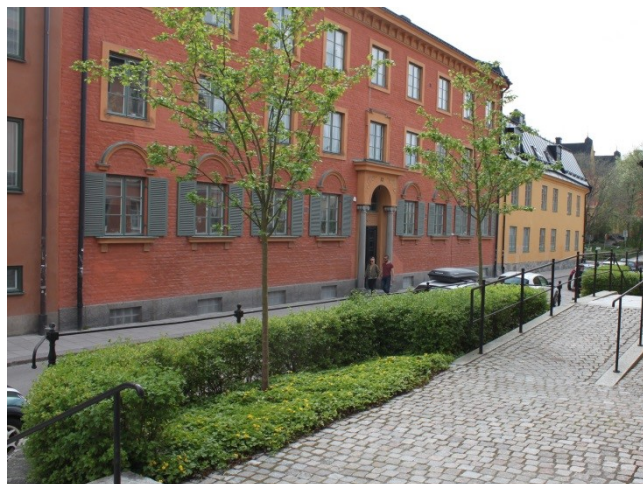
Bostadshus i tre plan läng S:t Johannesgatan i sten med inredd vind och plåttak, uppfört 1929.
