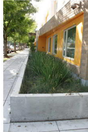
Figur 15. T.v. Principskiss för nedsänkt växtbädd. Ovanpå bädden skapas en fördröjningsvolym. Växtbädden kan dräneras till befintlig mark eller via dräneringsledning till dagvattenssystemet. T.h. Växtbädd som tar hand om takdagvatten via stuprör. Bildkälla: Stockholm Vatten och Avfall.
