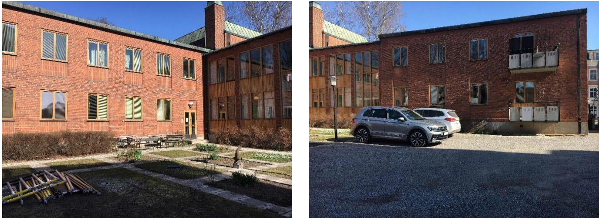
Figur 3. Foton från platsbesök. T.v. Nuvarande innergård med plantering och markplattor. T.h. Grusparkering på innergård. Ett av fastighetens stuprör syns till höger på fasaden.
