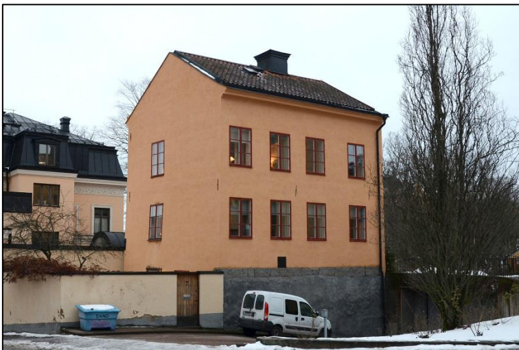
Stenhuset sett från nordväst.
