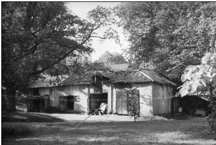
Bild från tomt nr. 7 som visar det stall som C E Cederström lät uppföra vid mitten av 1800-talet men som idag är rivet. Foto: Okänd. Ur rivningsdokumentationen i Uppsala stadsarkiv.
