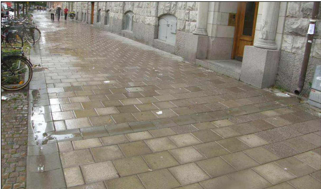
Figur 5-4. Exempelbild på rännalarnas funktion vid nederbörd (Foto av Örjan Stål och Björn Embrén).
