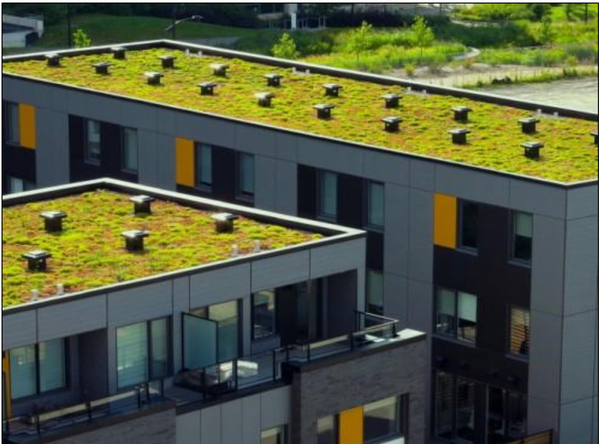
Figur 5-6. Exempelbild på sedumtak i stadsmiljö (Bild: Ljugsedum).
