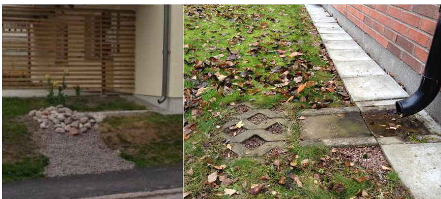
Figur 5. Utkastare med erosionsskydd/infiltration.
