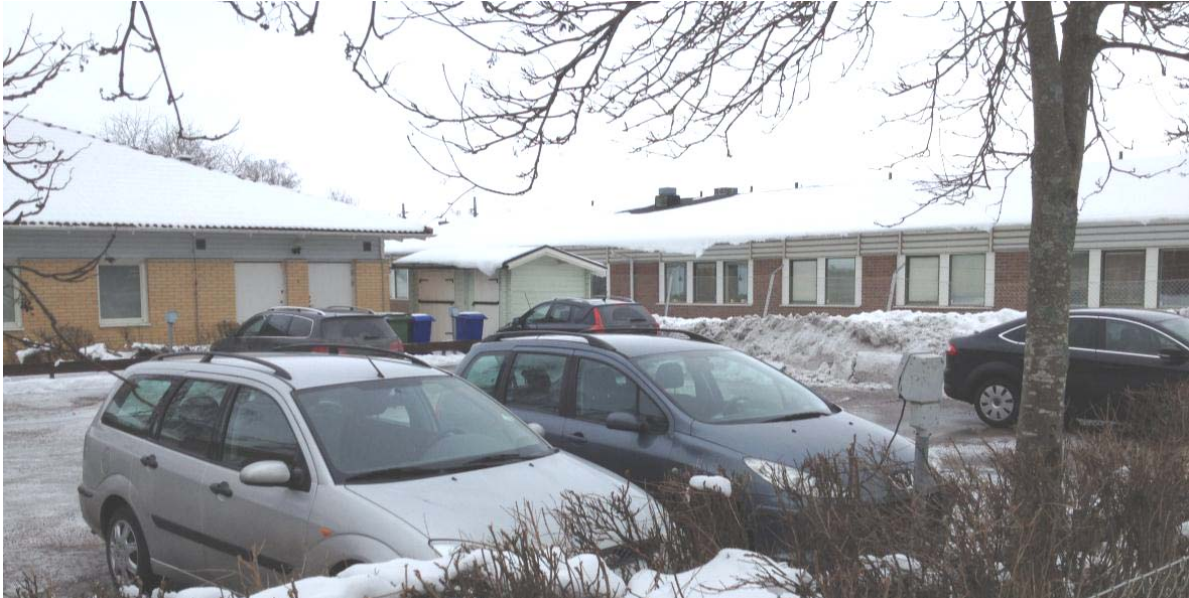
Fastigheterna Kvarngärdet 1:8 och 62:1 som är avsedda att bebyggas med bostäder. Fotot är taget i februari 2013, sett från Portalgatan.
