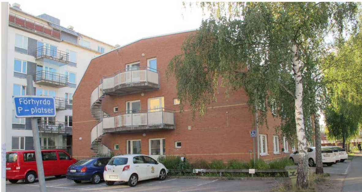
Fastigheten Kvarngärdet 62:2 i den södra delen av planområdet och angränsande bostadsbebyggelse i söder. Fotot är taget i september 2014, sett från Portalgatan.
