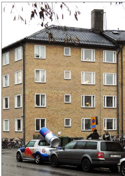
Hus D från Karlsrogatan. De två byggnadsetapperna framträder som en skarv i takfallet. Den höga skorstenen hörde till de tre oljepannor som fanns i den del av byggnaden som uppfördes i etapp 1, till höger i bild. Taken är täckta med svartglaserat falstegel.
