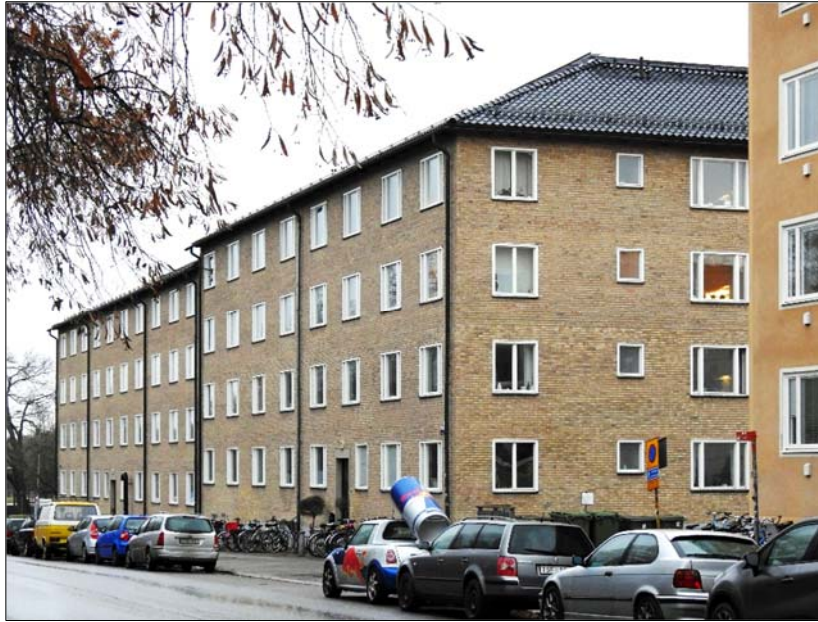
Hus D (etapp 2). Fasad mot Karlsrogatan.
