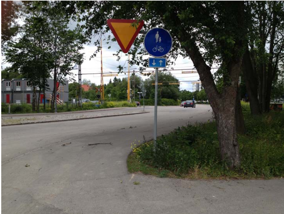
Befintlig järnvägs korsning vid Ringgatan.
