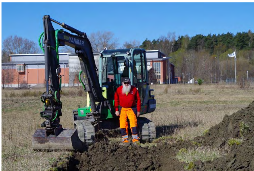
Figur 2. Pedor Jansson med maskin framför Vattenverket. Foto: Mattias Ahlbeck
