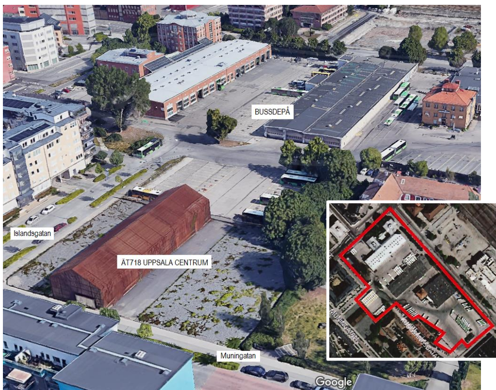
Figur 1. Översikt av ställverk ÄT718 i anslutning till bussdepån (källa: Google Maps).
