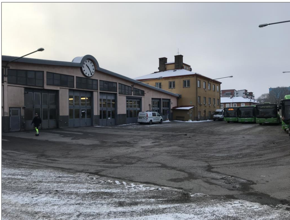
Foto 1. Lågpunkt i asfalten intill bussgaraget.
