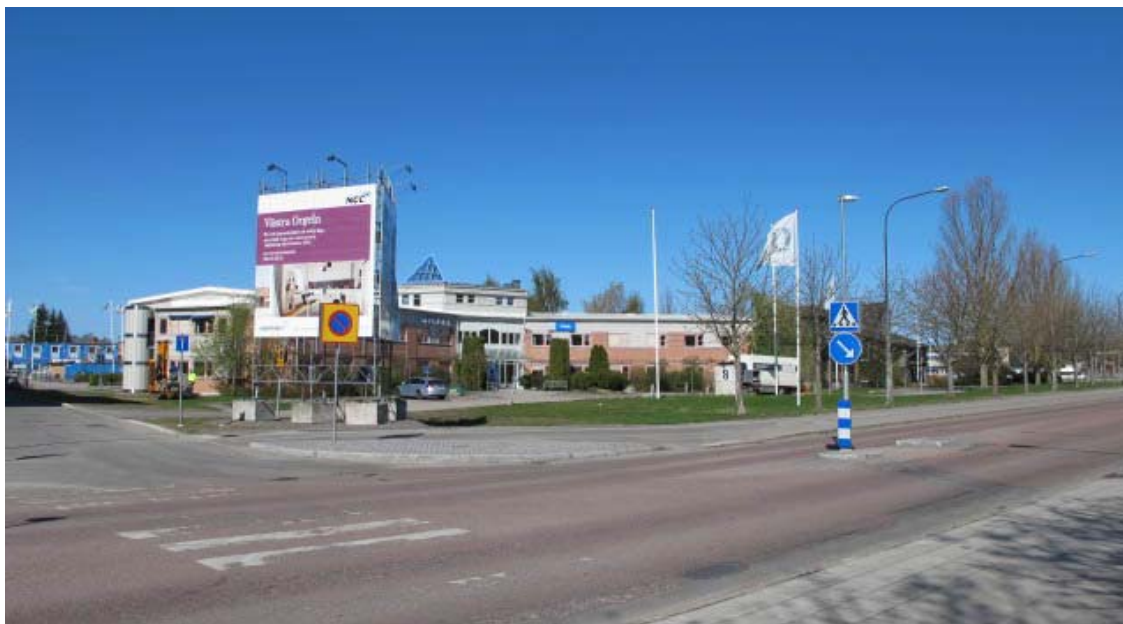
Foto som visar det södra kontorshusets fasad mot Vattholmavägen. Fotot är taget i april 2014.
