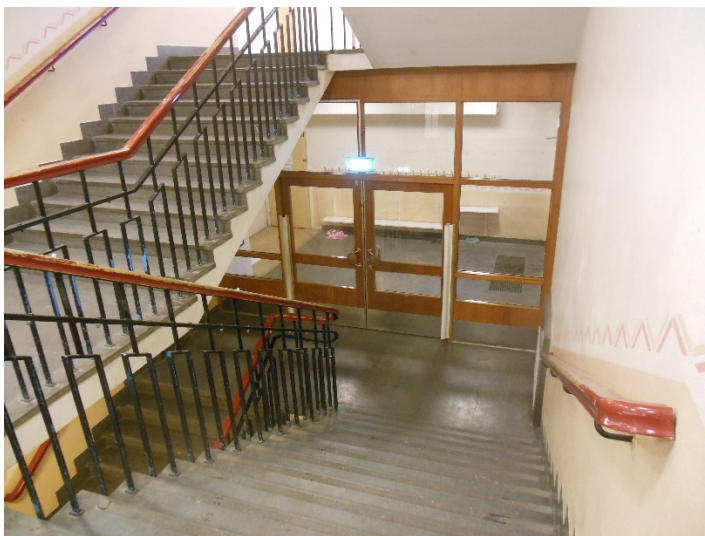
Trapphus med bevarat träglasparti. Trappräcket är ursprungligt, men räckesöverliggaren har höjts för att klara dagens säkerhetsstandard.
