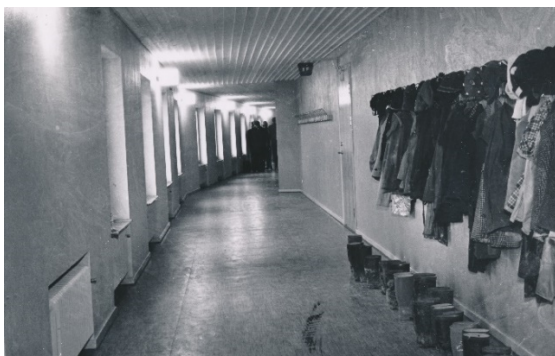
Korridor/kapprum med fönster, bild från invigningsåret
