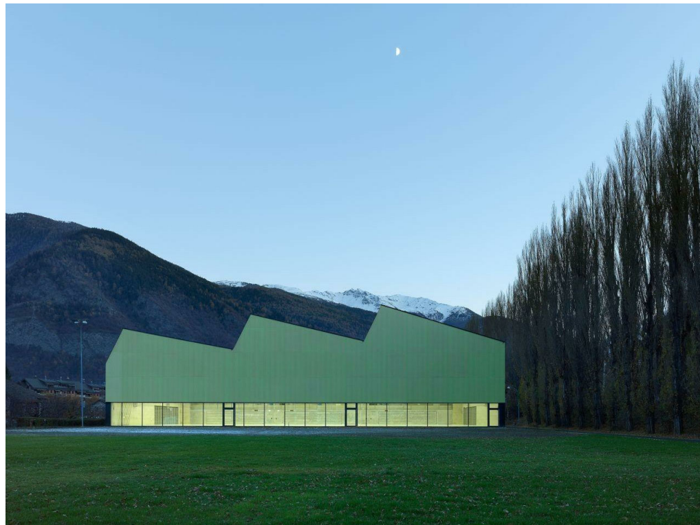
Exempel på lösning för dagsljus i idrottshall. Taklanterniner med ljusinsläpp i norrläge. Visp sportscenter. Savioz Fabrizzi Architectes
