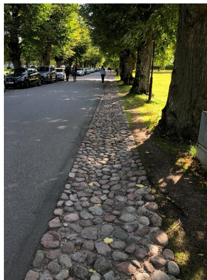
Figur 18. Principskiss av makadamdike till höger, foto av dike som exempel på utformning med genomsläpplig beläggning för infiltration och skålad yta för avledning av höga flöden (foto Caroline Dahl).
