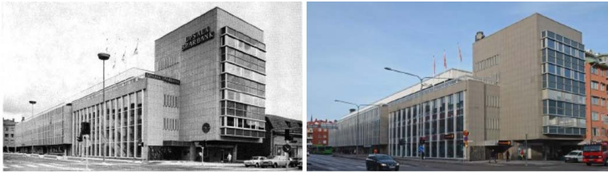
Uppsala sparbank strax efter att den stod färdig 1972. Huset stod i princip som en solitär längs Kungsgatan. Foto ur boken Bygghus i Uppsala 1966-71.
