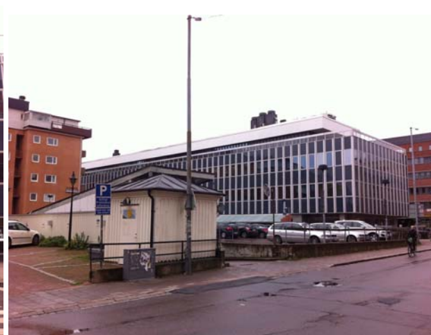
Planområdet mellan Tingshuset (utanför bild till vänster) och Sparbankshuset. Ytan mellan byggnaderna består till stor del av markparkeringar.
