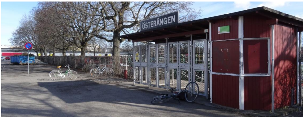
Figur 3 Huvudentré till befintlig anläggning
