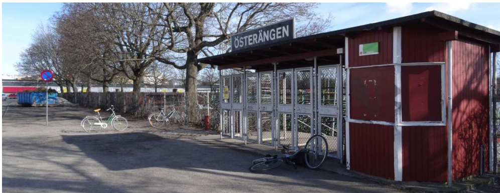
Figur 3 Huvudentré till befintlig anläggning
