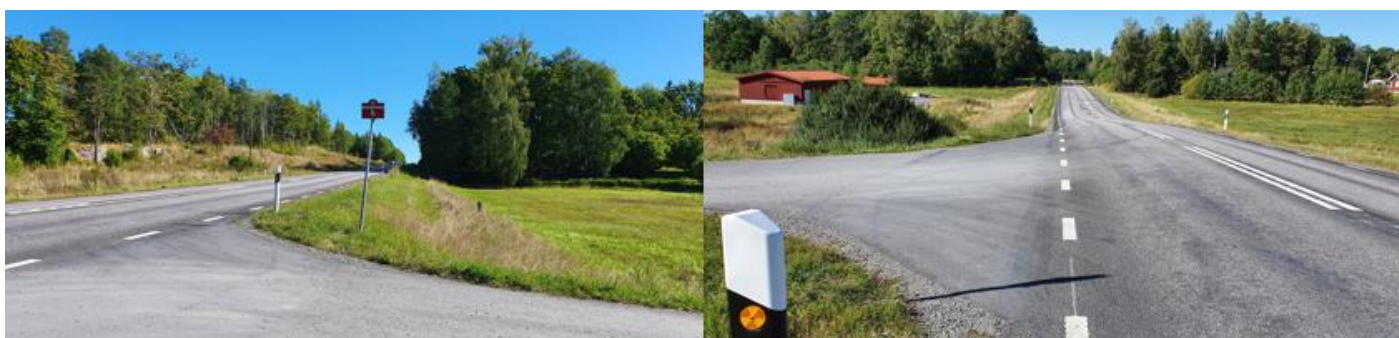
Figur 13 - Korsningspunkt vid punkt 10 i Figur 3.
