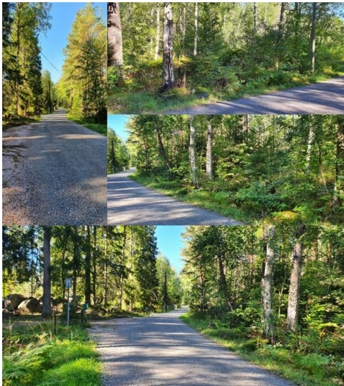
Figur 6 – Befintlig plats för ny angöringsväg vid punkt 3 i Figur 3.
