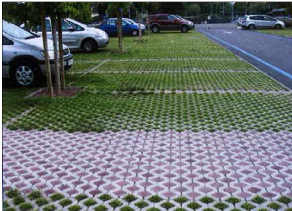
Bild 11. Förslag på avvattning av parkeringsytor och parkeringsytor med armerat gräs.
