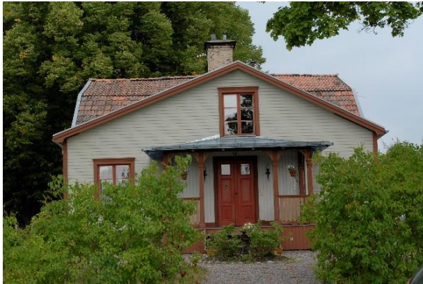
Bostadshuset på fastighet 59:4
