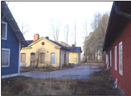
Figur 28; Byggnaderna i Fyrkanten.
