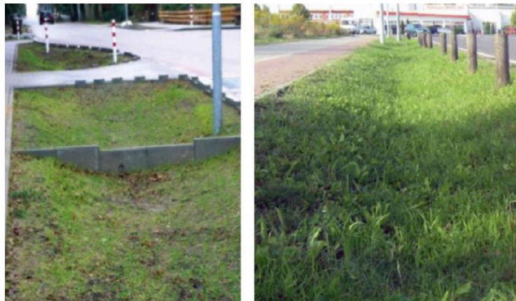
Figur 14. Exempel på hur svackdiken kan utformas. Bilderna kommer från Stockholm Vatten och Avfall.
