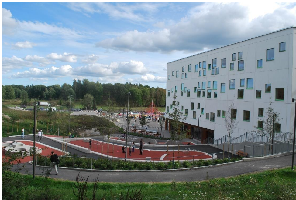
Exempelbild på skolgård, vid Glömstaskolan i Huddinge, där skolbyggnaden delvis placerats med hänsyn till höjdskillnaderna på platsen. Foto Maria Hernberg.
