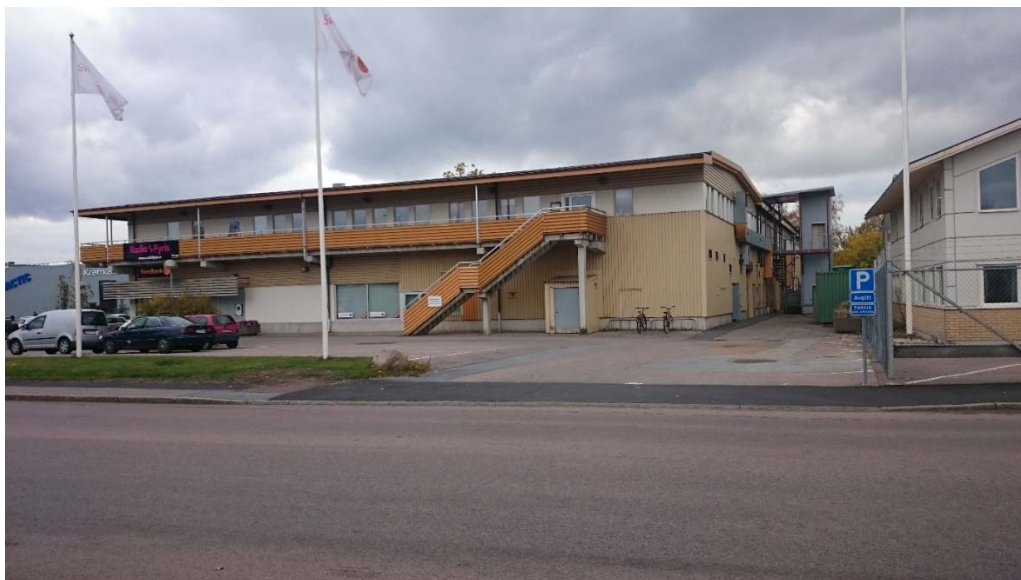
Den befintliga byggnaden sett från Björkgatan.
