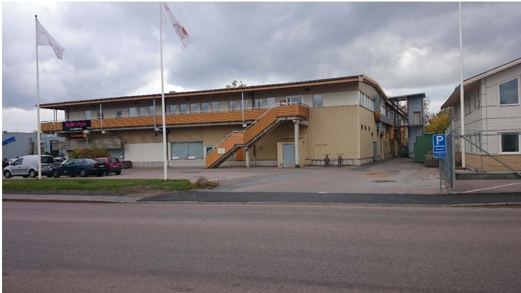
Den befintliga byggnaden inom planområdet sedd från Björkgatan.
